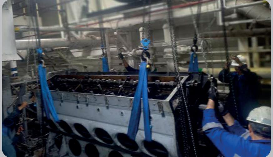
RFM Motors a engagé depuis février 2022 des grandes réparations (Révision générale, révision intermédiaire et réparation accidentelle) sur trois (3) groupes électrogènes EMD de type 645-E8 de fourniture d'énergie équipant une plate-forme pétrolière.
